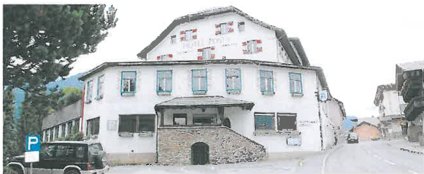
Seit Oktober 2010 ist das Hotel Post geschlossen. Bauherr Walter Stoll will noch heuer im Inneren mit den Umbauarbeiten beginnen. Foto: Paschingner
