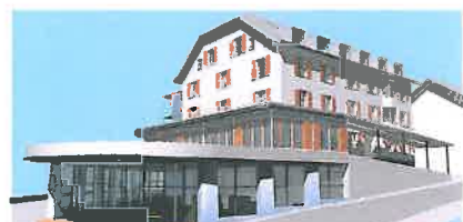
Die geplante Vorderansicht des Komplexes: Der Kern des markanten und beherrschenden Hauses bleibt bestehen. Layout: Arzlerhof, Kramers, Fritz
